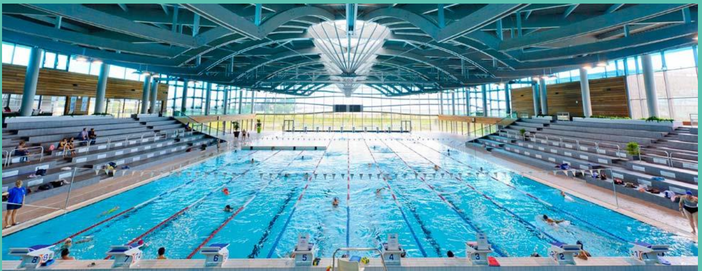
Piscine Olympique du Grand Dijon (bassins intérieurs de 50m et 25m)
